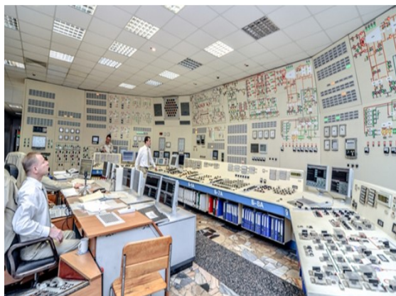
Рис. 1. Тренажер пульта керування атомної електростанції
